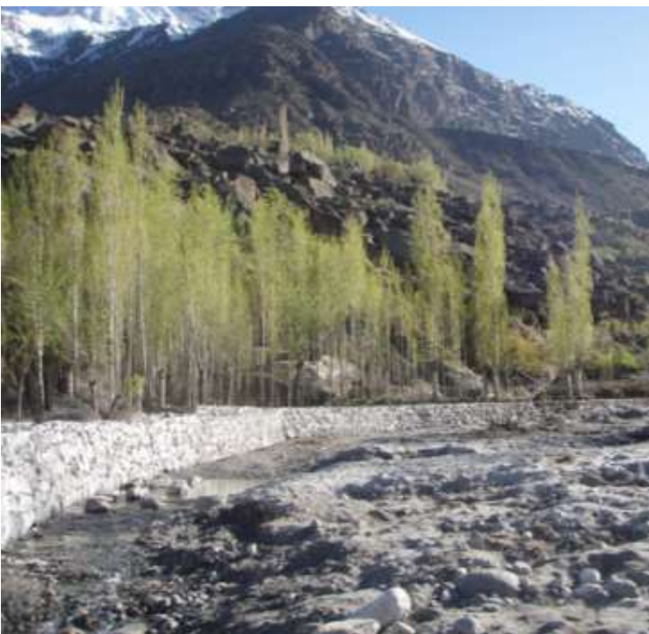
完成した防水壁
