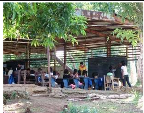
台風により崩壊した校舎
