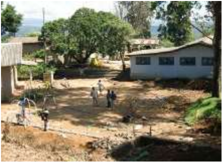
ハプタレー幼稚園の遊具とグラウンド工事全景。右奥園舎に接し「オープンスペース」が出来る
