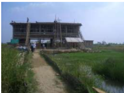
写真7 視察地(チェッシャー村) BAJ エンジニアが考案した沿岸地域対応型の学校建設現場 政府規定のものより安価(1/3程度)で建設が可能
